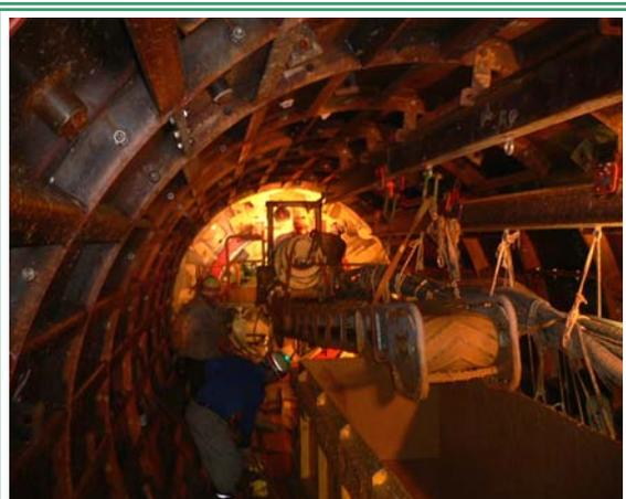
送水管布設工事（シールド工法）の坑内作業状況
